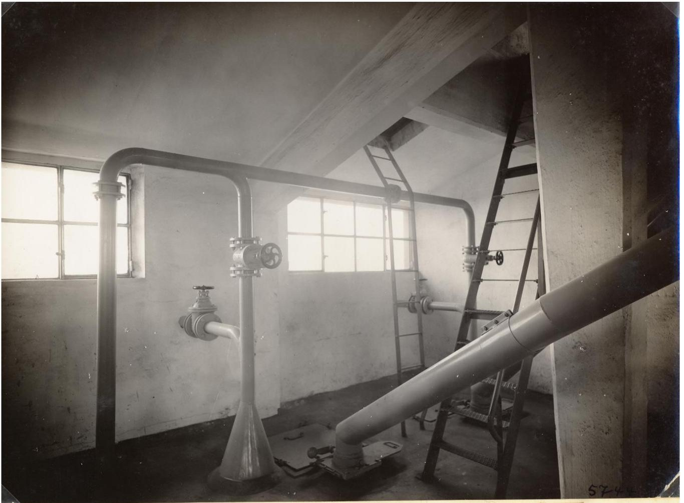
Absaughauben, Begasungszellen mit gasdichtem Einlauftrichter, Iñzehoe
